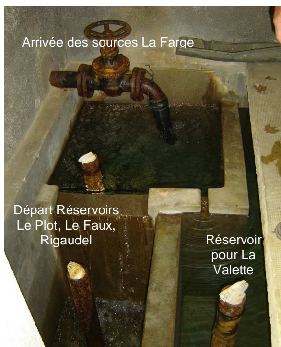
Figure 7 : Intérieur du réservoir de la Fage
